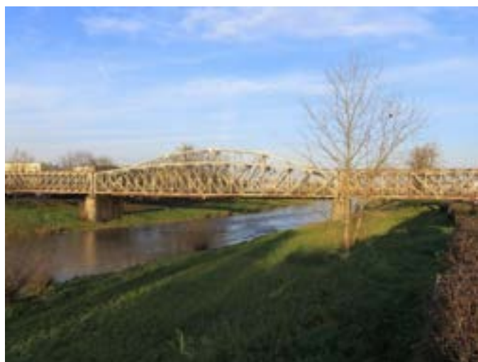
Rys. 9. Most kolejowy na Sanie w Przemyślu [11]
