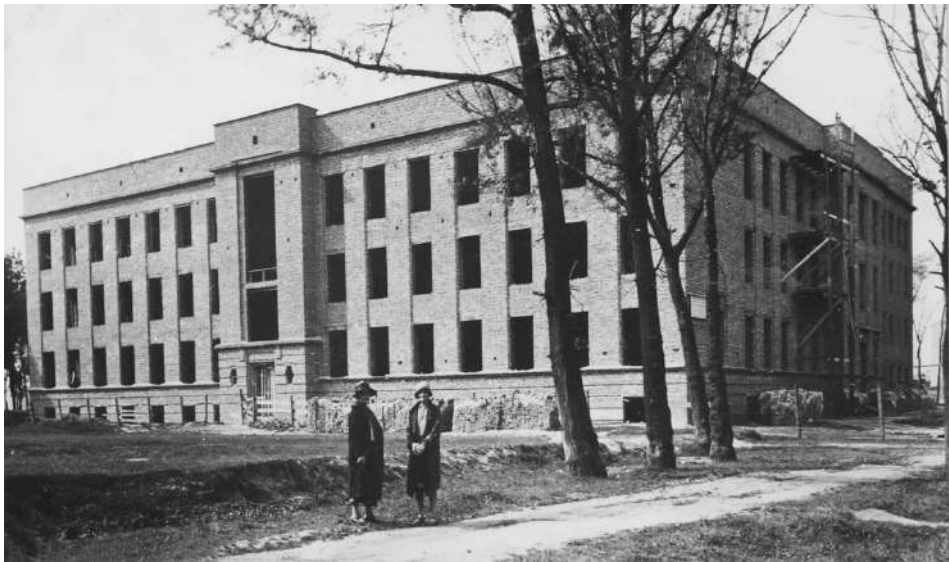
Rysunek 5. Instytut Radowy w trakcie budowy. Pierwsza z lewej Bronisława Dłuska. Archiwum Polskiego Towarzystwa Chemicznego Figure 5. Radium Institute under construction. First from the left is Bronisława Dłuska. Archive of the Polish Chemical Society
